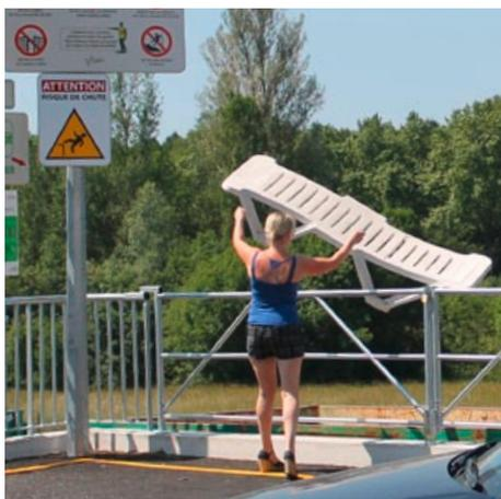
Depuis 2012, un arrêté impose des dispositifs antichutes sur toutes les déchetteries dotées d’un quai d’une hauteur supérieure à un mètre. Le Syded a choisi d’installer des garde-corps mobiles qui sont moins contraignants que des murs pleins, même si les dépôts sont moins faciles qu’auparavant. La sécurité des usagers reste la priorité.
